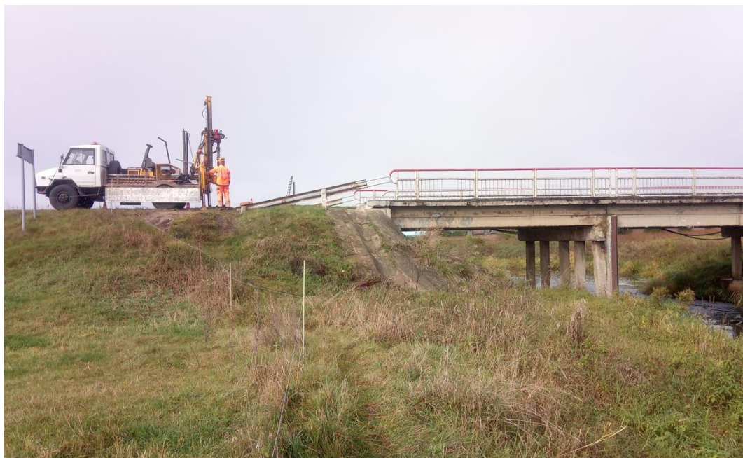
1 pav. Lauko darbai
